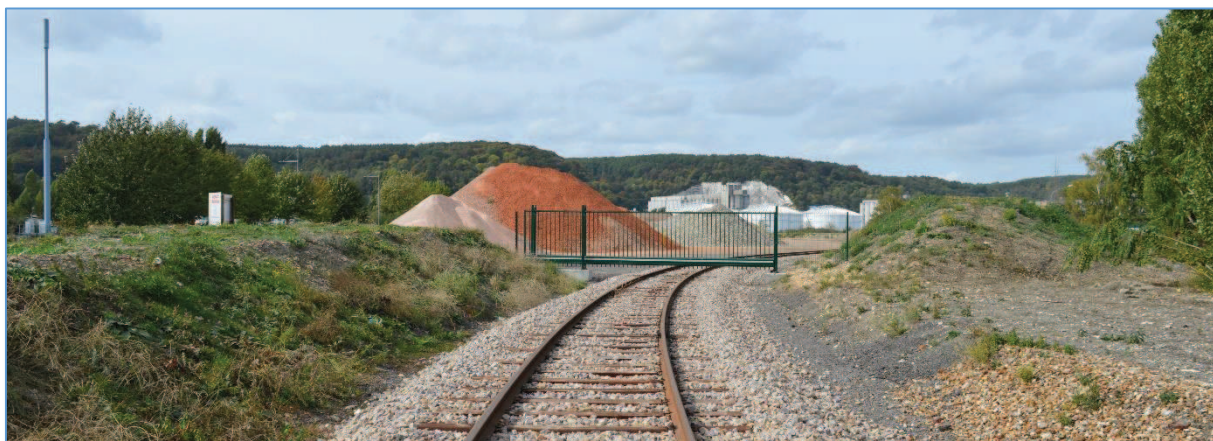
Fig. 12 : Photographie n°4 : Accès pour les trains
