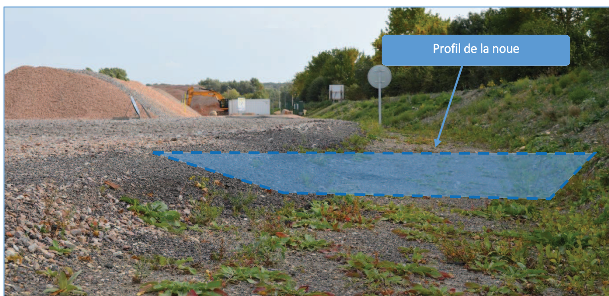
Fig. 15 : Photographies n°8 : Vue sur la noue d'infiltration des eaux pluviales (partie aval au Nord du site)
