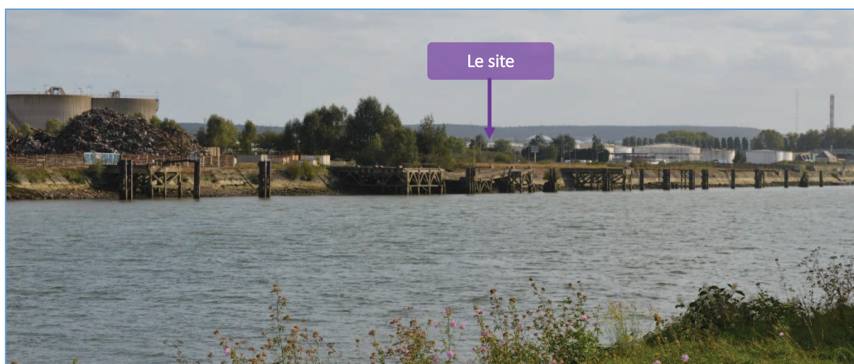
Fig. 46 : Vue F éloignée sur le site depuis la rive opposée de la Seine
