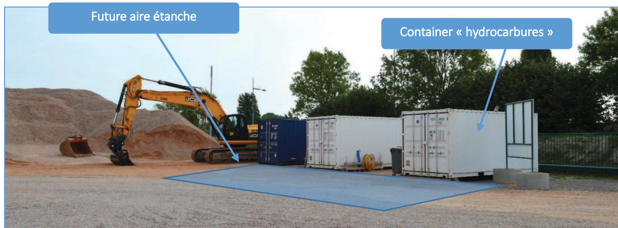
Fig. 36 : Container « hydrocarbures » fermé à clé
