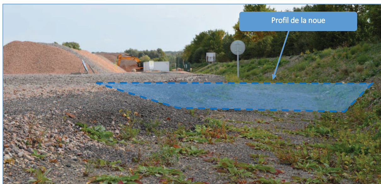
Fig. 35 : Photographies n°9 : Vue sur la noue d'infiltration des eaux pluviales (partie aval au Nord du site)
