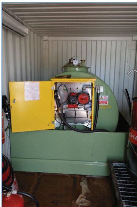
Fig. 37 : Cuve GNR 3000 L sur rétention et kit anti-pollution
