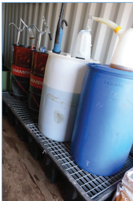
Fig. 38 : Stockage des huiles sur rétention
